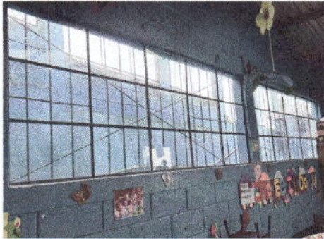
Foto 3: Finalización cambio de vidrios rotos.
