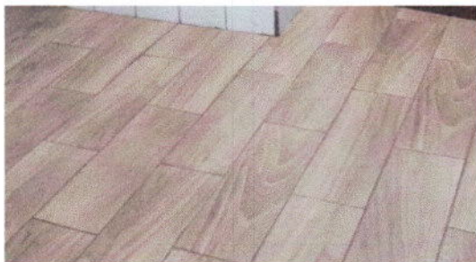
Foto 3: Finalización cambio de piso cerámica
