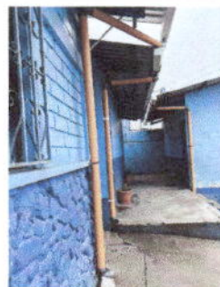
Foto 6: Finalización cambio de canales de aguas pluviales bajadas de agua.
