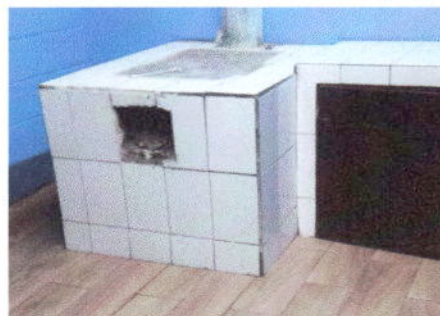
Foto 2: Finalización del cambio de plancha de cocina.
