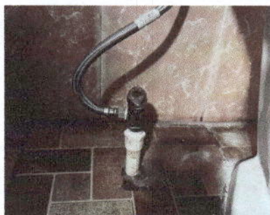
Foto 5: finalización cambio de llave en sanitario de niñas.
