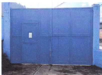
Foto 1: Finalización del cambio de portón principal de ingreso.
