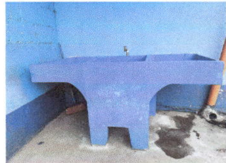
Foto 2: Finalización cambio de pila.
