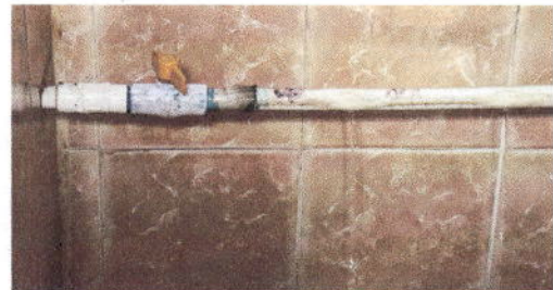
Foto 4: Finalización cambio de llaves en mingitorio.
